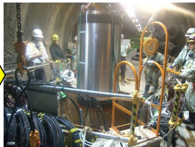
オーバーパック・緩衝材の設置
