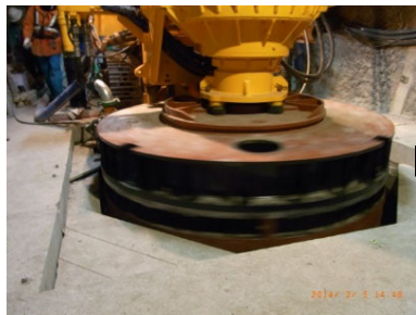
大口径掘削機によるピット掘削
