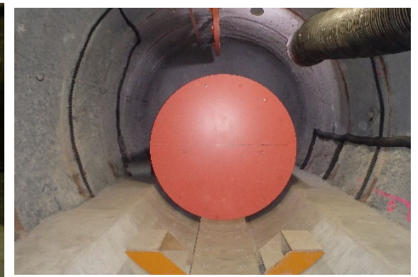
模擬PEMの設置状況
