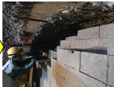
坑道の埋め戻し
